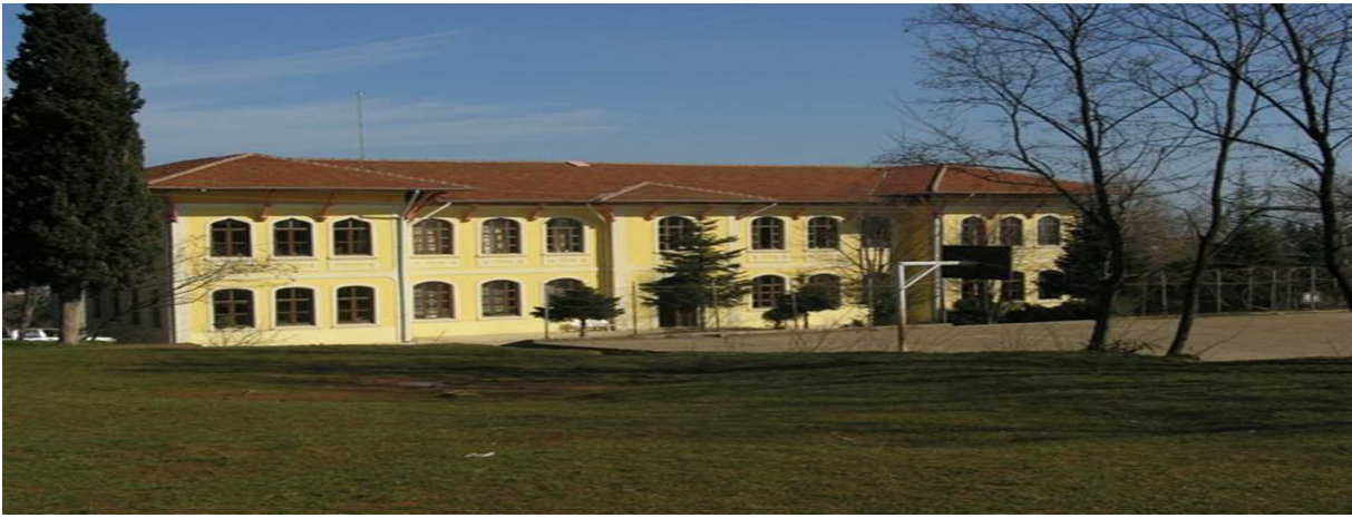
Şekil 2. Orhan Gazi İlkokulu Giriş Cephesinden Görünüş (Türkiye Kültür Portalı, 2013).
