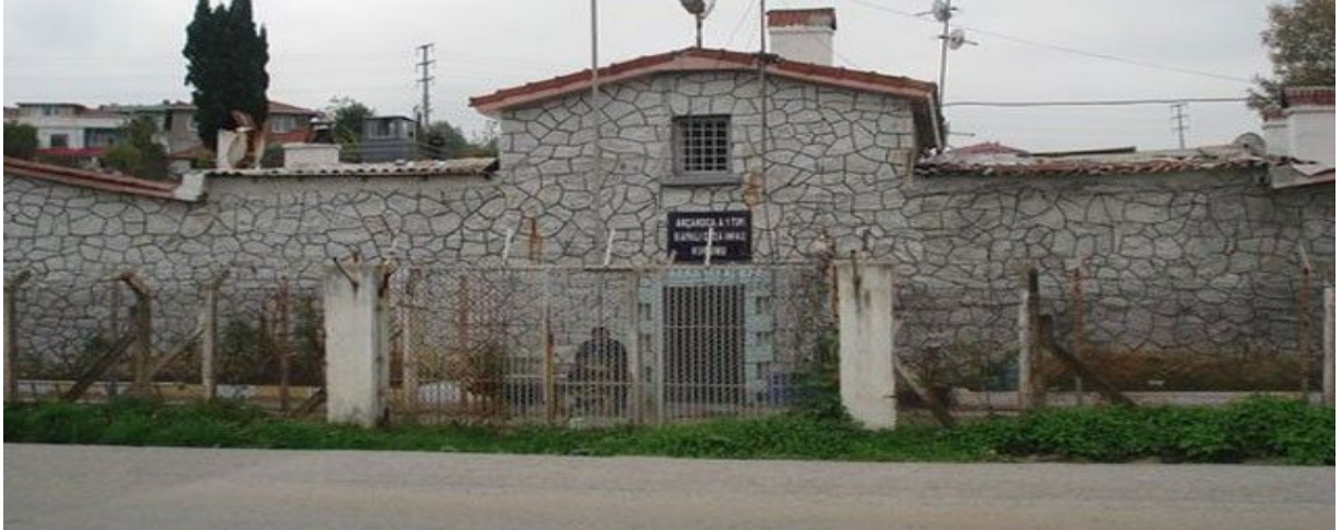
Şekil 1. Akçakoca Cezaevi Giriş Cephesinden Görünüş (www.duzceparantez.com).
